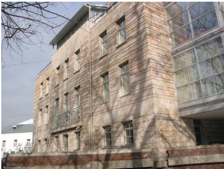
**1999-2000** год. Отделка фасада элитного жилого дома по адресу Зачатьевский пер., г.Москва. Отделка произведена эксклюзивным материалом песчаник «Russian Gold». Поставка материалов, выполнение архитектурных деталей, монтаж. Объем работ 500 кв.м. (фасад).
