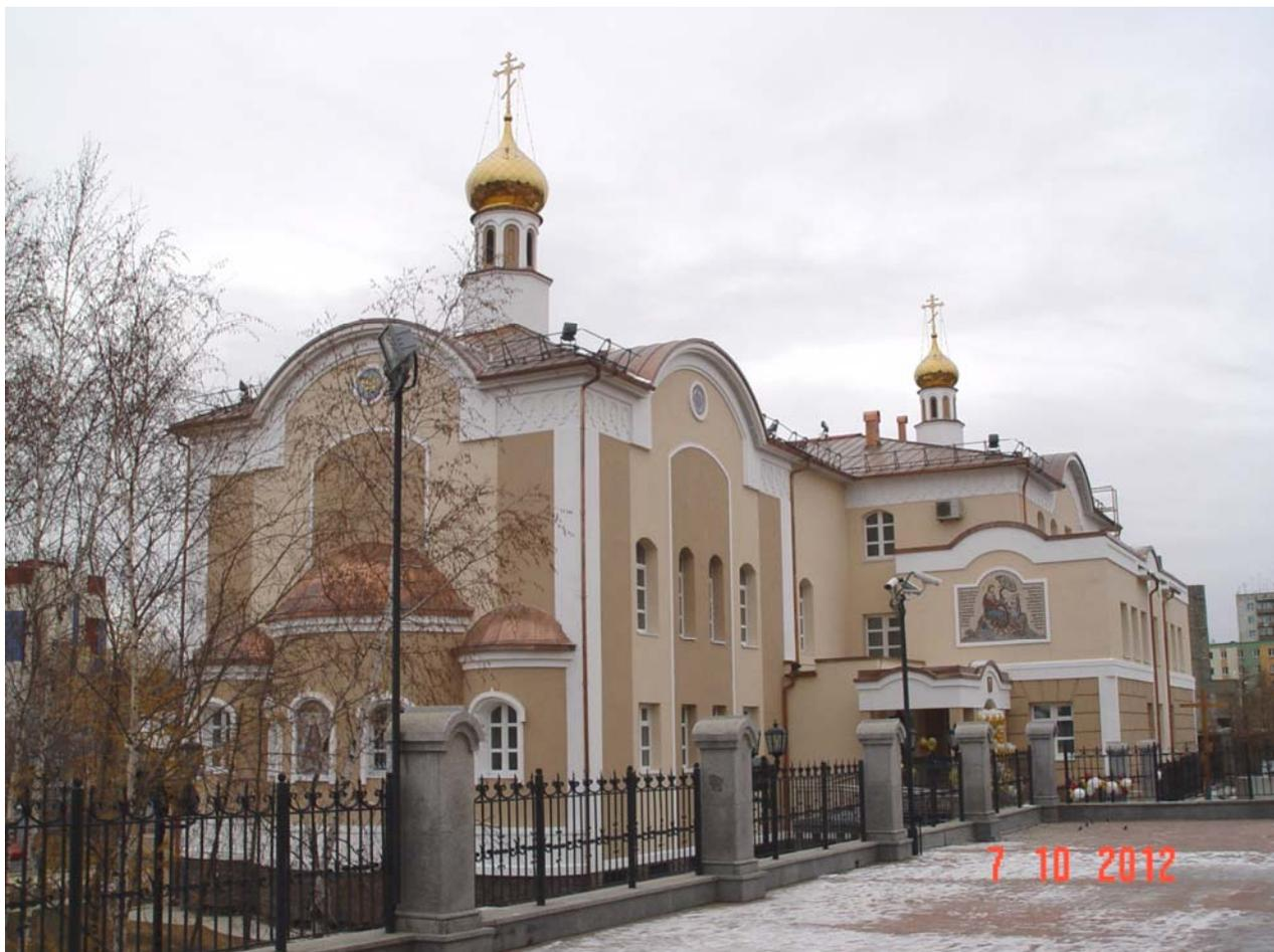
Облицовка подпорной стены стилобата, стен ограды, столбов, 300 м.кв. гранитных изделий
