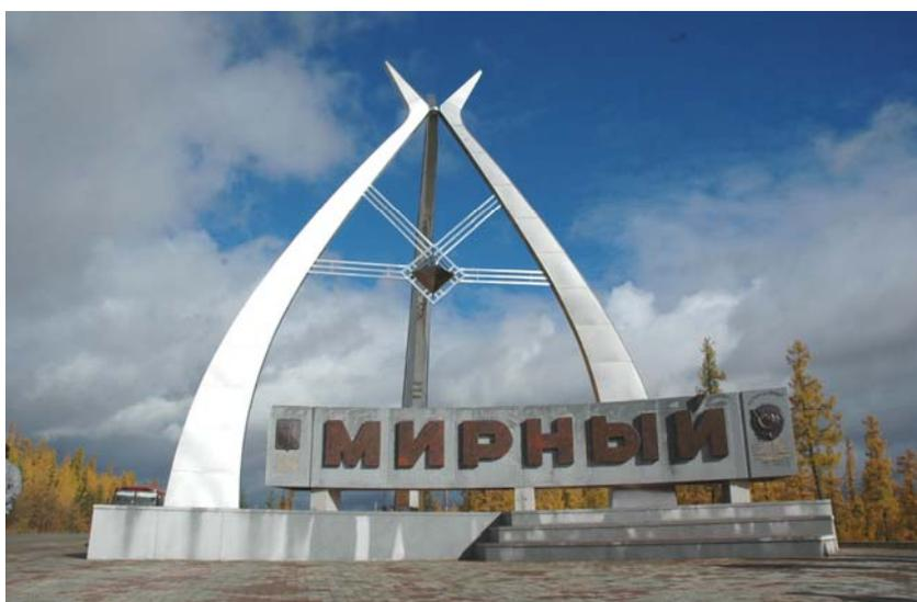
**2004г.** Комплекс работ «под ключ». Комплектация, поставка гранитных изделий, монтаж. Облицовка пилона и буквы из толстомерного гранита. Орден и герб на пилонах – бронза. Металлоконструкция облицована из нержавеющей стали. Заказчик АК «АЛРОСА».
